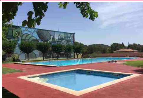
Nova piscina municipal més accessible i eficient i renovació del sistema de depuració de la piscina petita
