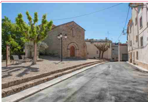
Reasfaltat del C/Major, Plaça Pau Vidal i C/Sant Pau
