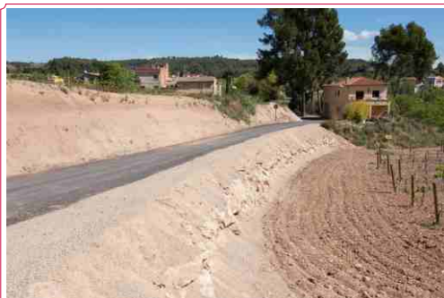
Actuacions de repavimentació i estabilització de talussos al camí de Cal Mussons
