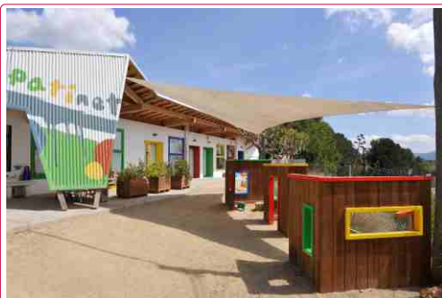
Col·locació de noves plaques solars a la llar d'infants
