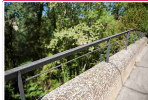
Col·locació d'una barana al carrer de la Font
