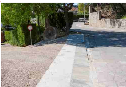
Construcció de vorera passat el pont del C/Molí
