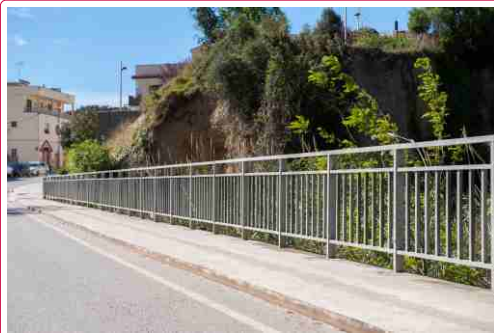
Millora de l'accessibilitat dels vianants en el pont del C/ Segismon Tomeu
